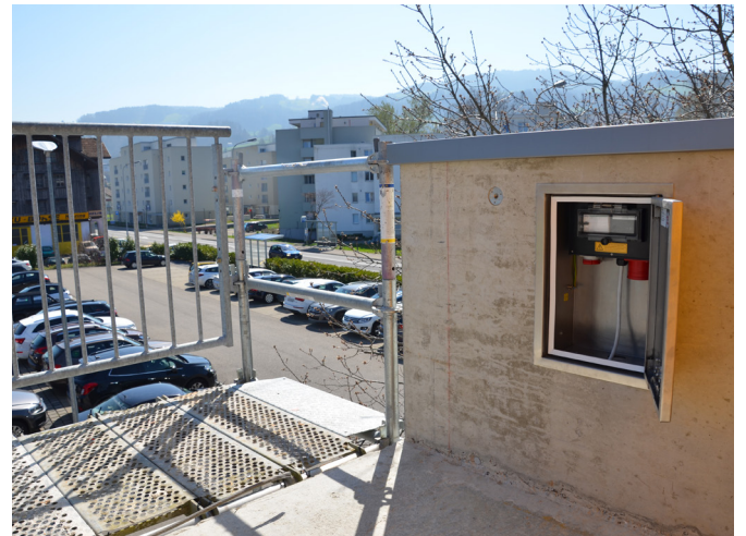
Distributore sotto muro incassato non ingombrante
