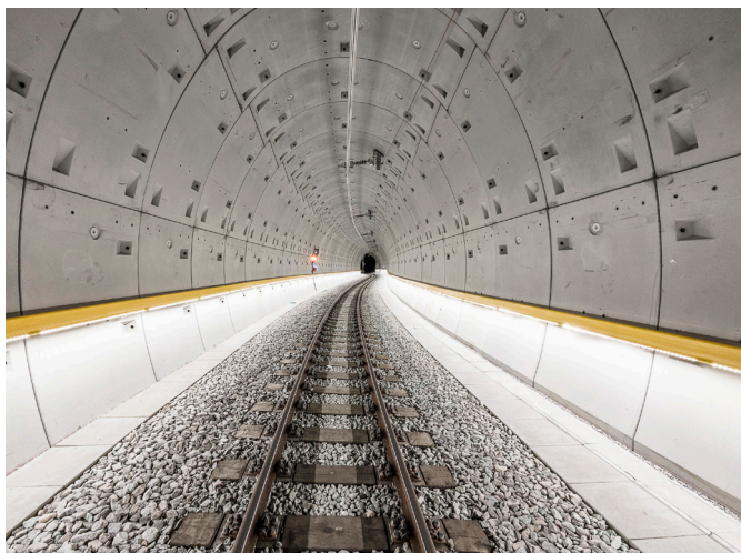
LaneLED GFK, galleria Glatscheras
